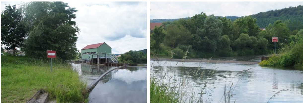
Abbildung 23: gut einsehbare wasserseitige Beschilderung der Gefahrenstelle (Wehr) in Dorndorf
