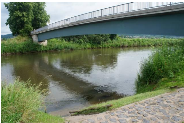
Abbildung 13: Das An- und Ablegen in Lauchröden wird durch Betonteile vom Brückenabriss behindert
