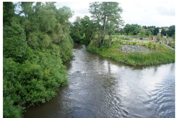
Abbildung 14: Die Einfahrt in den linken Flussarm in Bad Salzungen behindern Steine
