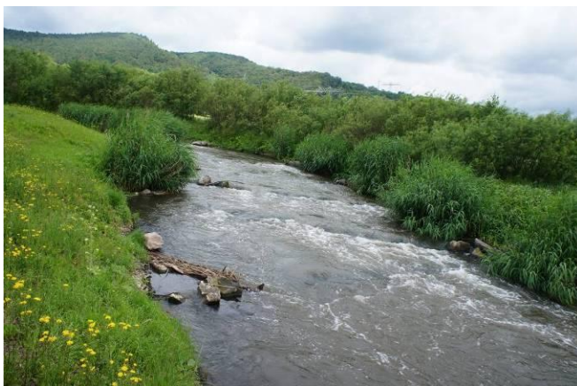
Abbildung 4: Naturnahes Umgehungsgerinne am Wehr in Sallmannshausen
